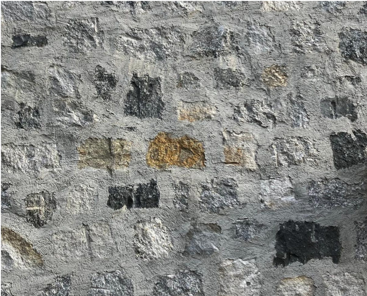
MAUERWERK FÜR TEILFLÄCHE NEUBAU
